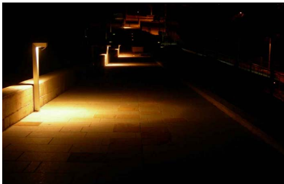
Intervento "La Cementifera": apparecchi di proprietà privata. Percorsi di uso pubblico illuminati con paletti segnaletici decorativi equipaggiati con sorgenti ad alogenuri metallici. Percezione fotografica notturna.
