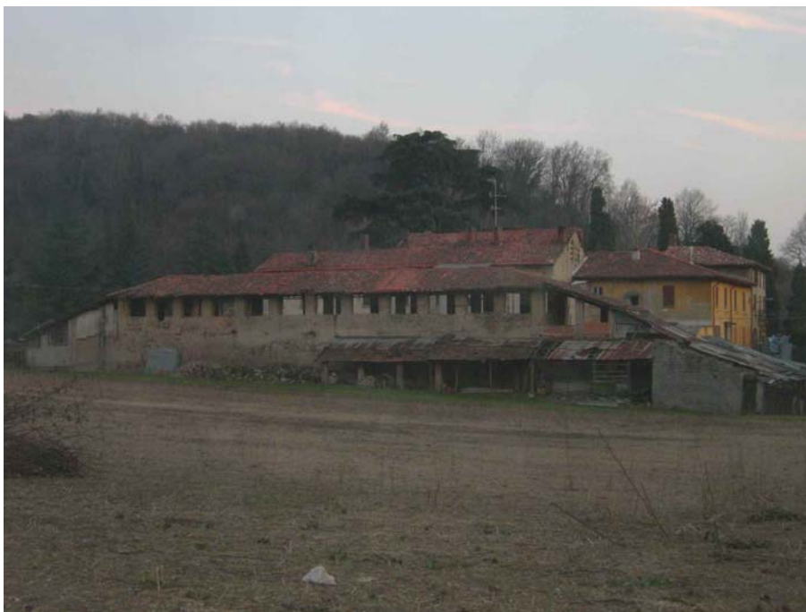
Cascina Moncucco: l'edificio risulta privo di illuminazione d'accento.
