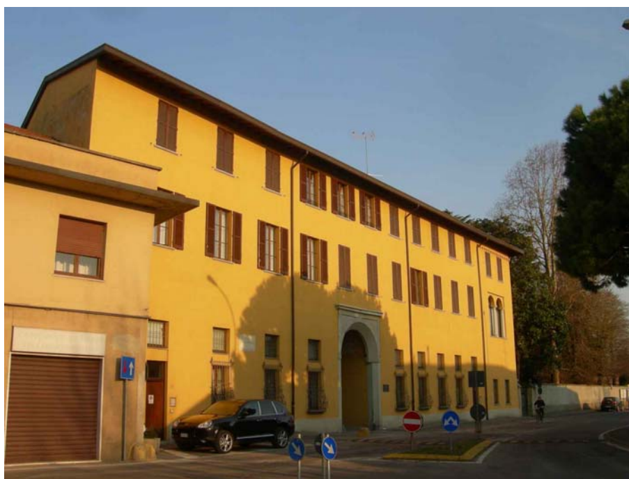
Palazzo Albini: l'edificio risulta privo di illuminazione d'accento.
