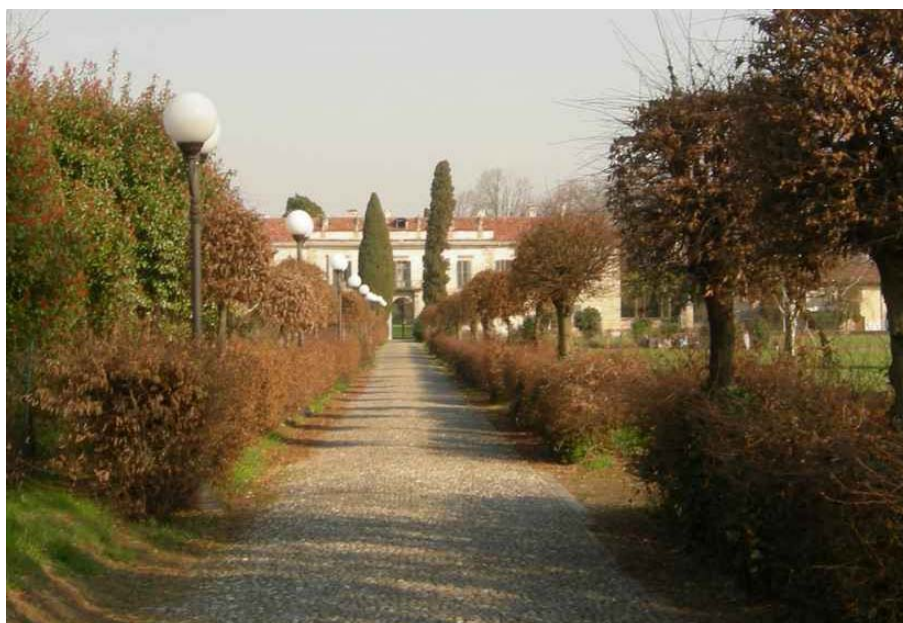
Via Della Vigna Chiusa: apparecchi di arredo urbano di tipo diffondente non conformi alla L.R. 17/2000 e alla L.R. 38/2004
