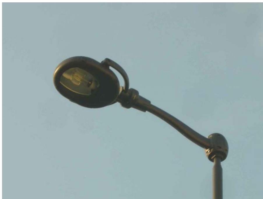
Piazza Strazza: apparecchio decorativo con ottica stradale totalmente schermato compatibile con le leggi regionali vigenti.
