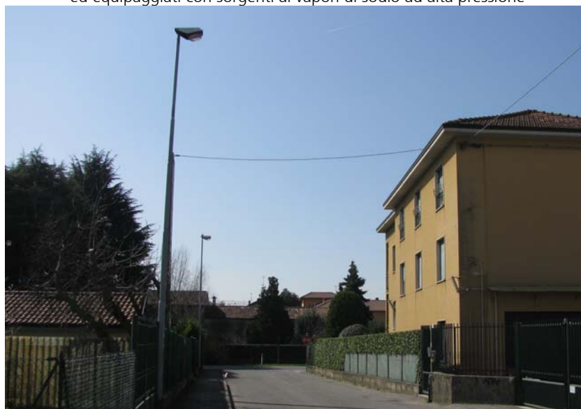
Via Garibaldi: apparecchi stradali dotati di vetro di chiusura a coppa diffondente ed equipaggiati con sorgenti ai vapori di sodio ad alta pressione
