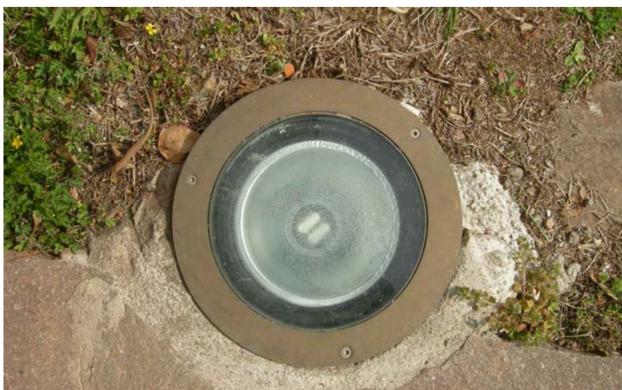
Incassi per l'illuminazione d'accento dell'ampliamento del cimitero
