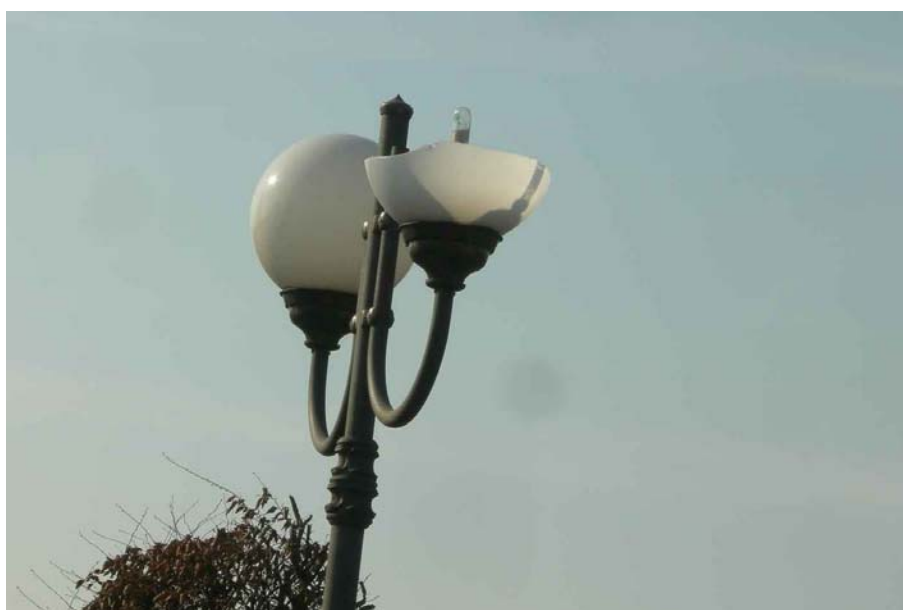
Via Della Vigna Chiusa: apparecchio danneggiato
