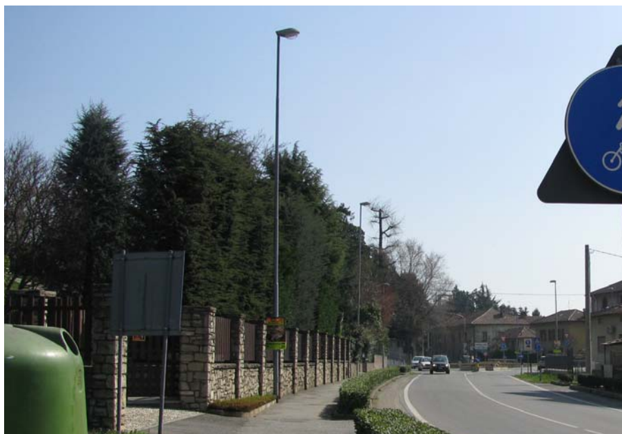
S.P. 54 : armature stradali dotate di vetro di chiusura a coppa diffondente ed equipaggiate con sorgenti ai vapori di sodio ad alta pressione
