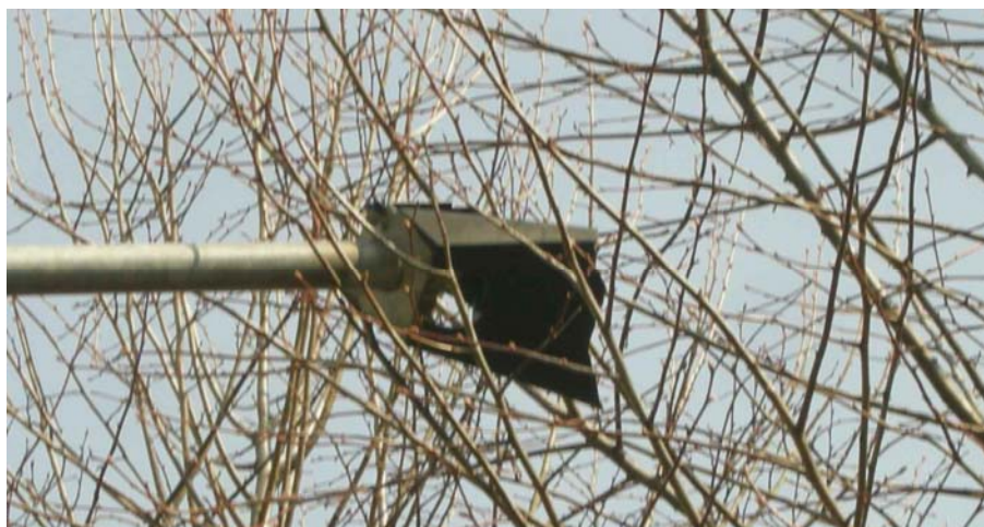
Via Dei Tigli: apparecchio danneggiato
