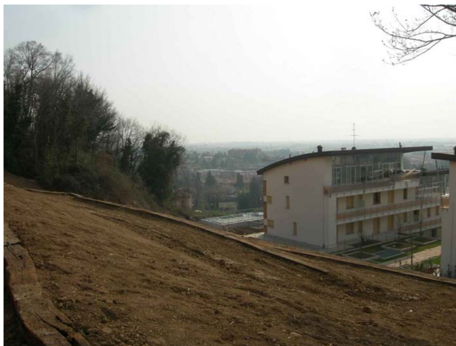
Ex cava – area verde “La Cementifera” in fase di realizzazione
