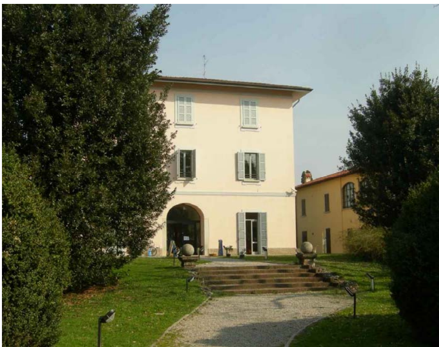
Villa Della Concordia: l'edificio risulta privo di illuminazione d'accento.
