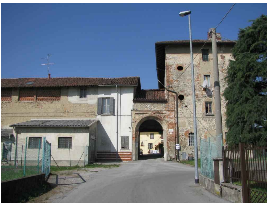
Castello Ganzana: l'edificio risulta privo di illuminazione d'accento.
