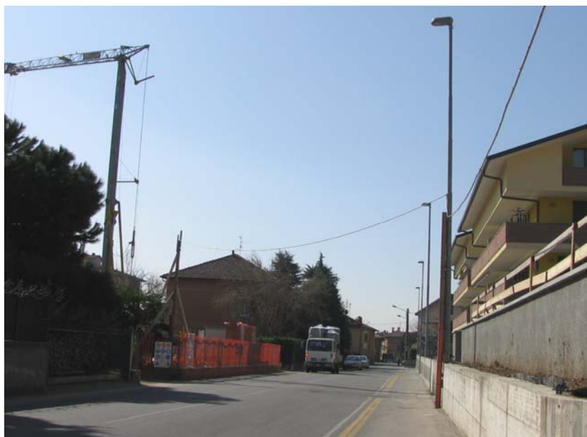
Via E. Bonfanti: apparecchi stradali totalmente schermati installati su palo ed equipaggiati con sorgenti ai vapori di sodio ad alta pressione
