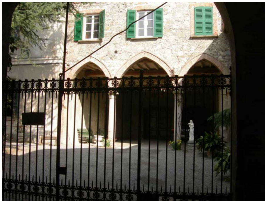
Portico storico di Via Indipendenza: l'edificio risulta privo di illuminazione d'accento.
