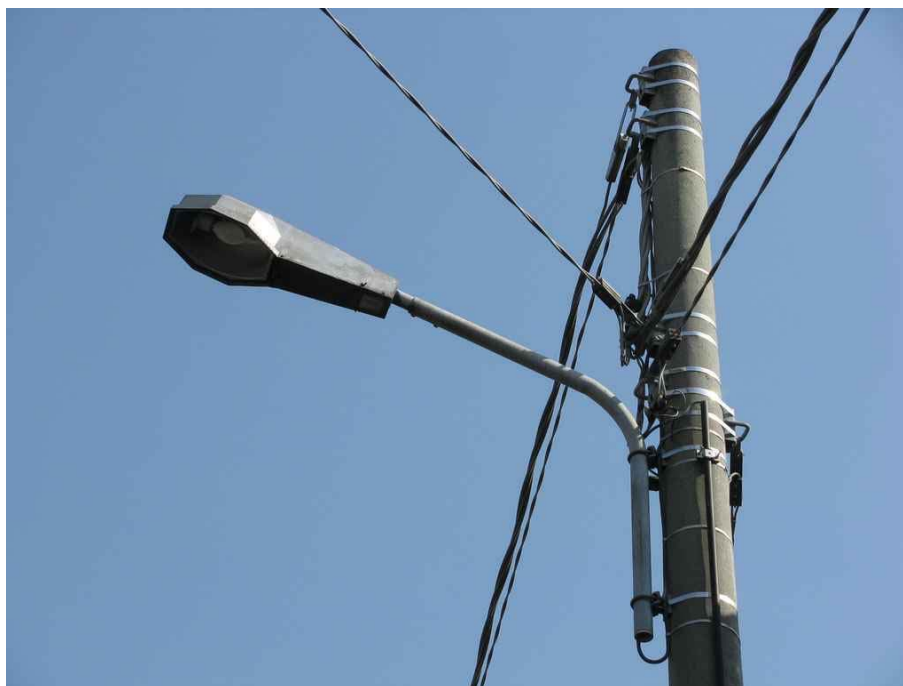
Via S. Colleoni: giunzioni di cavi su sostegno in c.a.c.
