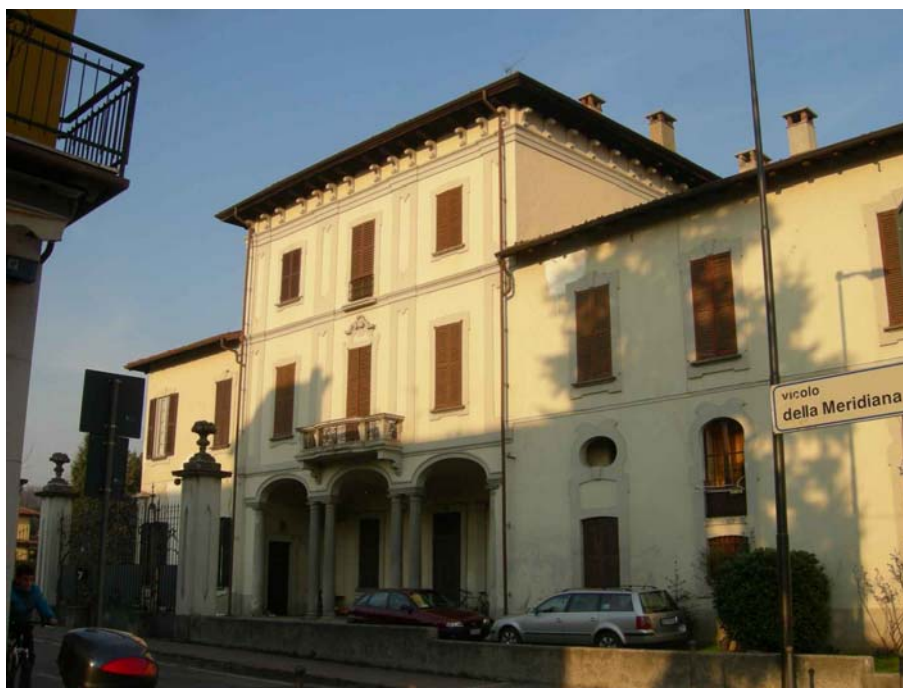
Palazzo Strazza: l'edificio risulta privo di illuminazione d'accento.
