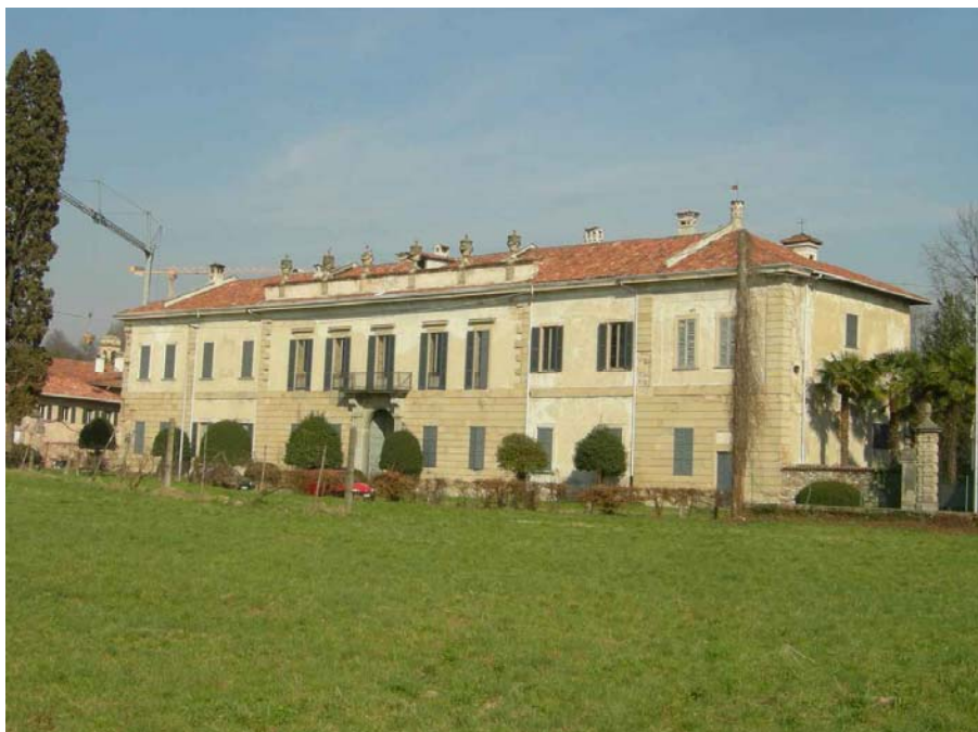
Palazzo Corio Brugnatelli: l'edificio risulta privo di illuminazione d'accento.
