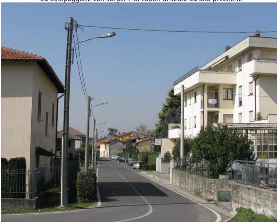
Via S. Colleoni: armature stradali prive di vetro di chiusura e dotate di sorgenti obsolete ai vapori di mercurio
