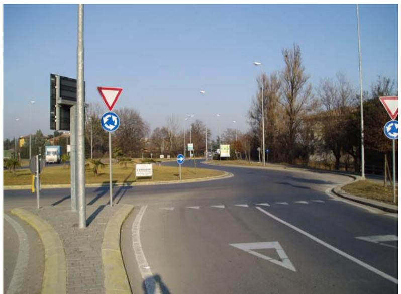
Una parziale riduzione delle dimensioni della rotatoria, in modo da minimizzare la superficie da acquisire/espropriare da parte del Comune sul vertice Sud-Ovest della rotatoria, è possibile ma potrebbe però portare a problemi sia di deflusso complessivo che di manovra dei mezzi articolati.
